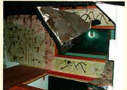
Hier bevond zich vroeger de studio. Zelfs de geluidwerende platen zijn verwijderd. De lijmresten zitten er nog.
